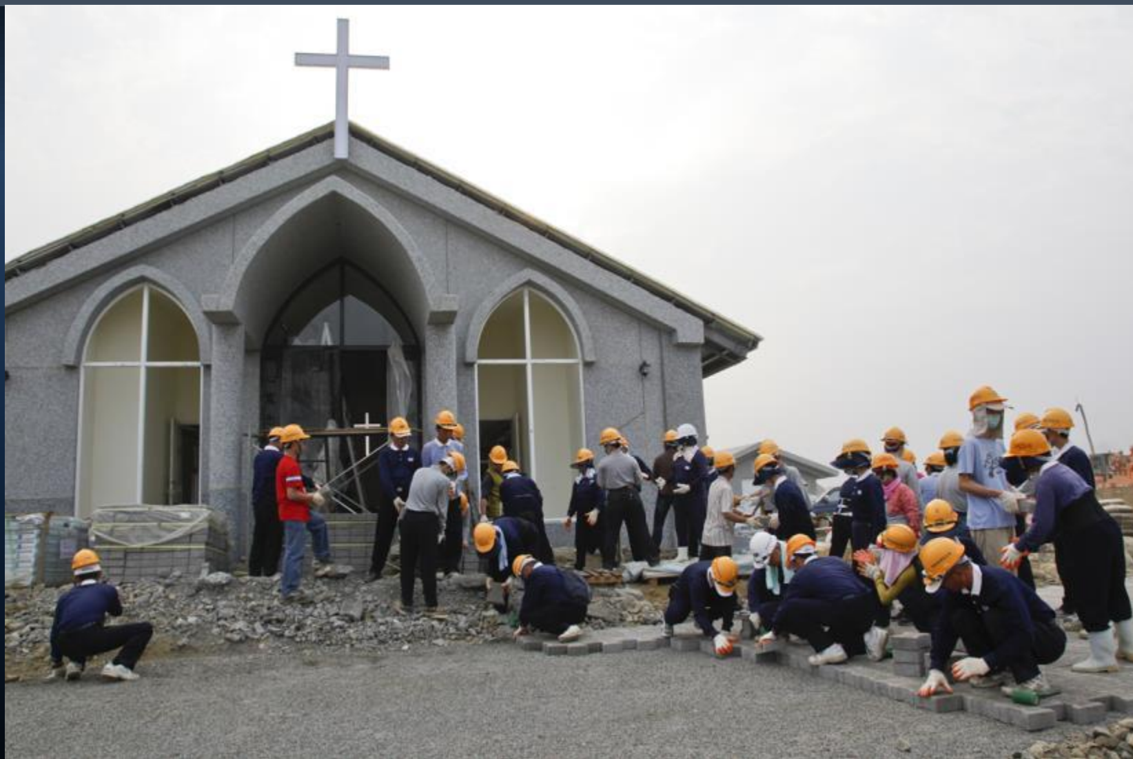
高雄杉林慈濟大愛園區援建工程，慈濟志工在園區內的教堂鋪設連鎖磚。 林炎煌攝 2010.02.08
