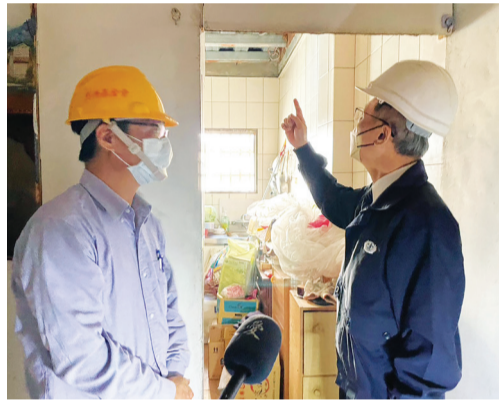
▲顏博文執行長（右）偕同相關處室主管同仁，針對受災戶屋況進行修繕勘查。（攝影：吳亞馨）
