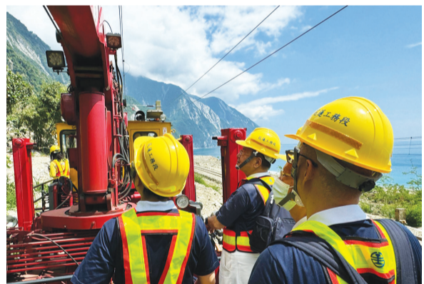
▲慈濟志工九月二日從崇德火車站搭乘工程維修車前往和仁至崇德間臺鐵小清水溪橋（西正線）慰問工程人員。（攝影：陳誼謙）
